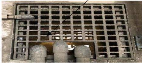
Figure 21 : Détecteur de présence de liquide dans la rétention
